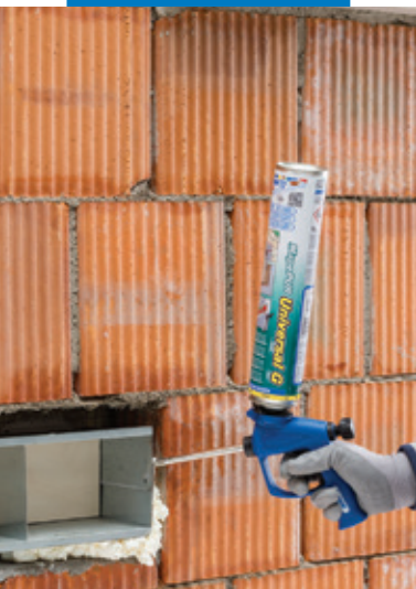
Riempimento di canale di ventilazione
